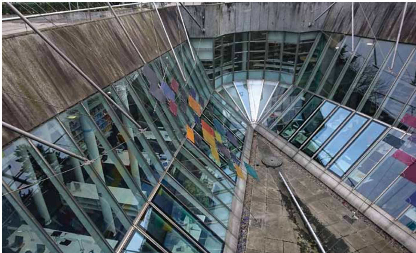
Podzemni del steklo-betonske fasade knjižnice v Bernu, vir: Neva Jejčič
