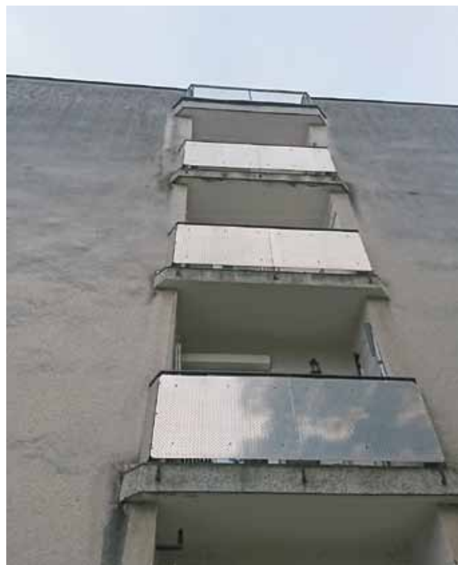
Severna fasada večstanovanjske stavbe brez nadstreška in napušča, vir: Neva Jejčič
